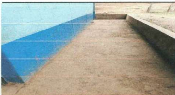
Foto 3: cambio de piso.
