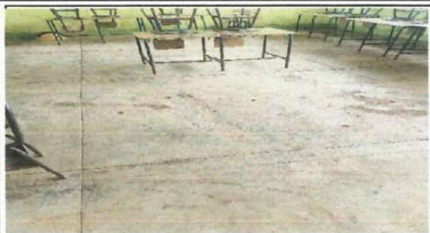
Foto 1: Cambio de piso a piso cerámico.
